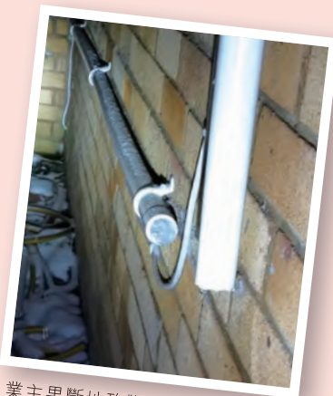
業主果斷地砍斷結了冰的水管，更換新的才能回復正常。
